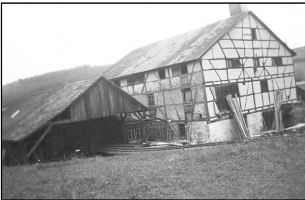
Die stillgelegte Ziegelei
